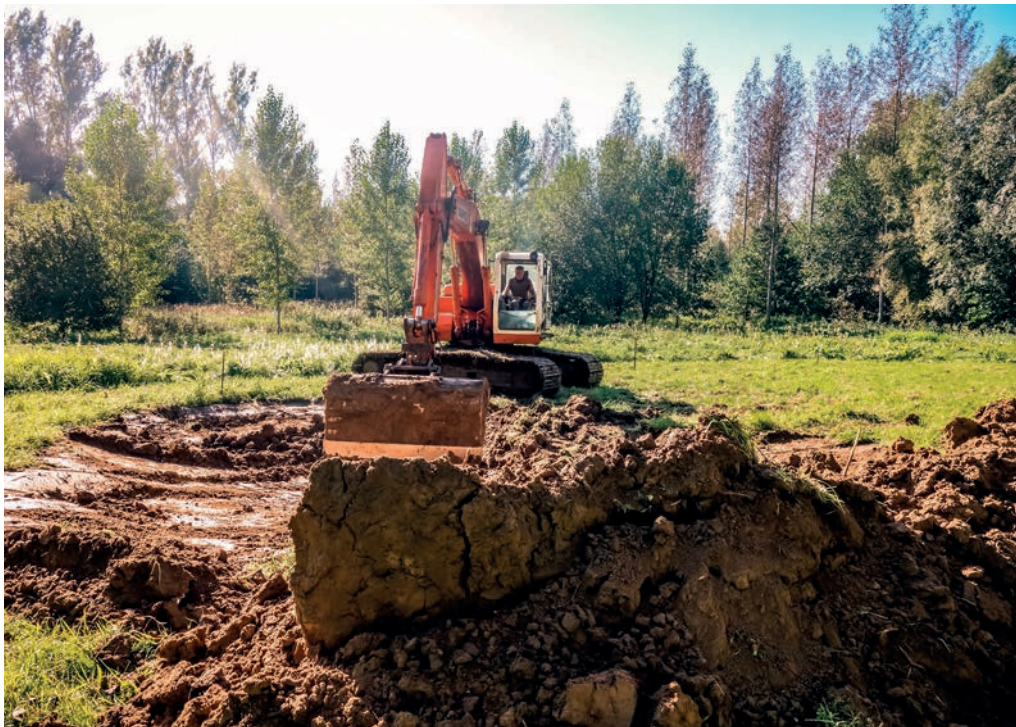
Aanleg amfibieënpool in de vallei van de Herkebeek, Voort
